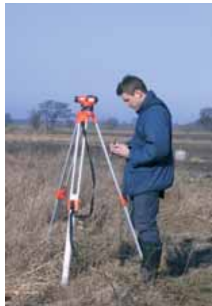
Rensningens djup bör kontrolleras med avvägningsinstrument.
