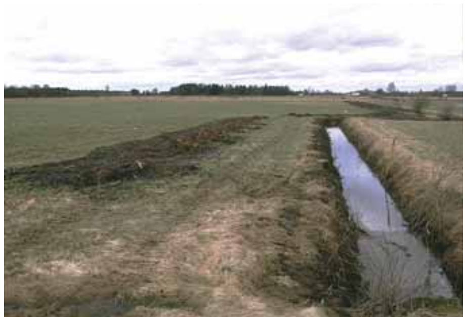
Rensningsmassorna skall placeras en bit från vattendraget och gärna läggas ut på åkermarken där de sen kan jämnas ut.
