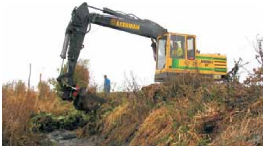
Dikensrensningar med grävmaskin bör övervakas så att rensningen inte sker till överdjup eller att hårdbottnar med sten och grus grävs upp. Finns hotade musselarter i vattensystemet bör uppgrävda rensningsmassor kontrolleras och eventuella musslor läggas tillbaka i vattnet.
