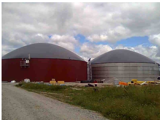
Bild 6. Samröttningsanläggning utanför Katrineholm under byggnation
