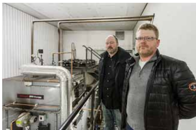
En flispanna av märket Aritem på 2000 kW effekt används. Foto: Diakrit
