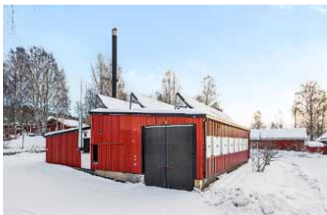
Flispannan är centralt placerad för att minimera kulvertlängden, och minska värmeförluster.
