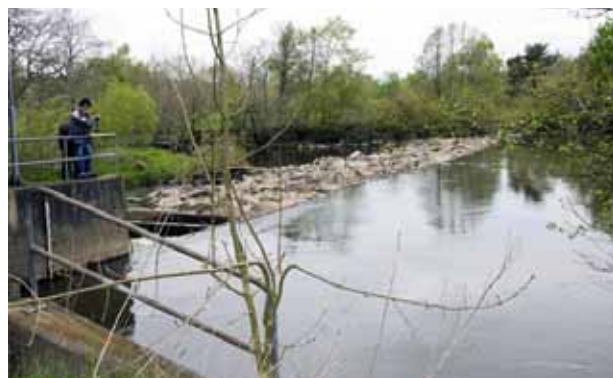
Dämnet i huvudfåran. Vid stora vattenföring rinner vattnet över skiborden och vid lägre säkerställs ett minsta vattenflöde på 2 m/s genom två hål på vardera 0,5 m i betongmuren. Foto från Hallands Vattenkraftsförenings hemsida.
