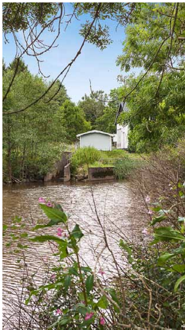
Nedströms Kullagård vattenkraft.
