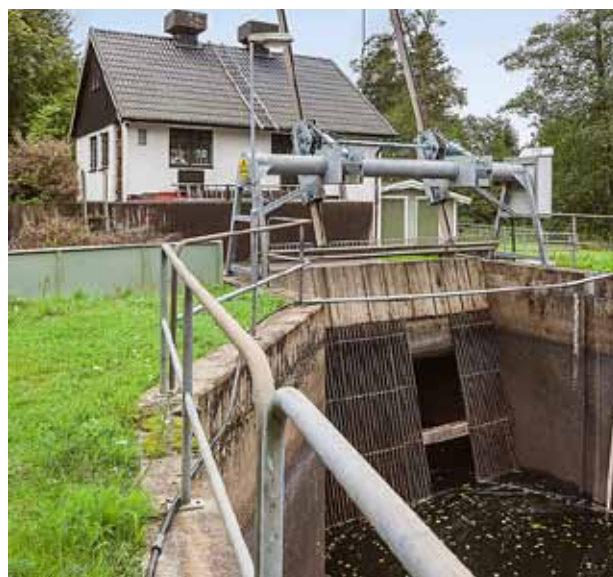
Kraftverket uppströms vid intagsgrindarna.
