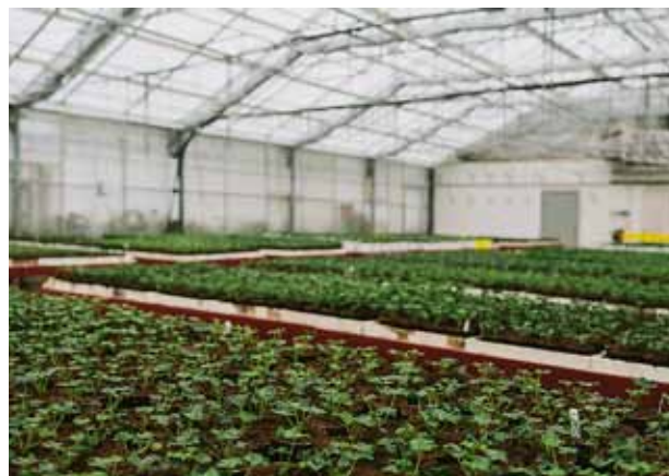
Växthuset om 2 000 m 2 värms upp med förnybar energi.
