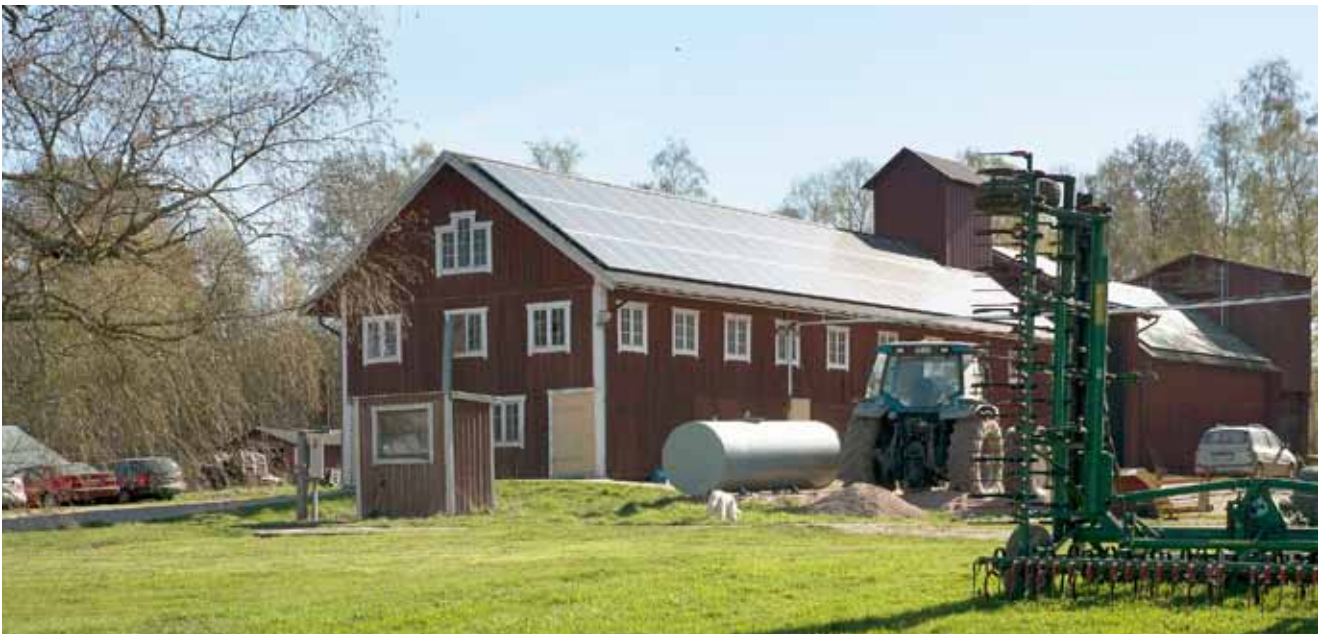
På Åskekärns Gård utanför Töreboda har Per-Anders och Monika Didriksson byggt solceller på ladugårdstaket. Elen används till ventilationen i svinstallarna och överskottet säljer de. Foto: Diakrit
